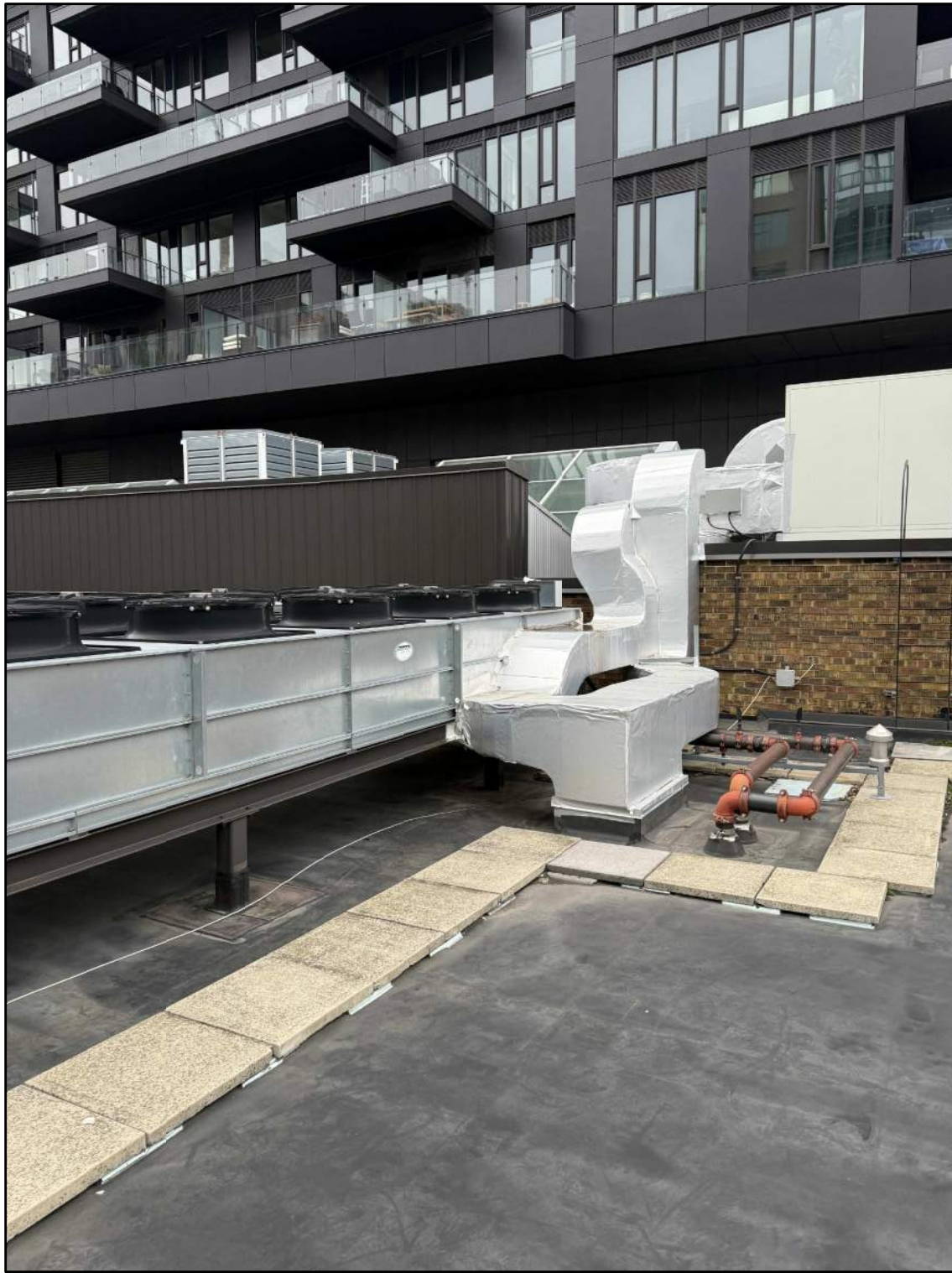
3 EXISTING FLUID COOLER 'FC-1' & PIPING M5 SCALE: N.T.S.
