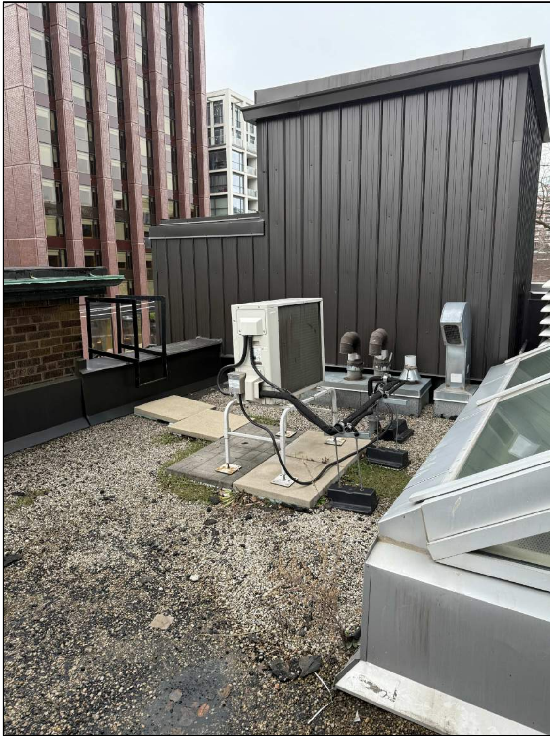
3 EXISTING CONDENSING UNIT, REFRIGERANT PIPING & GOOSENECKS M4 SCALE: N.T.S.
