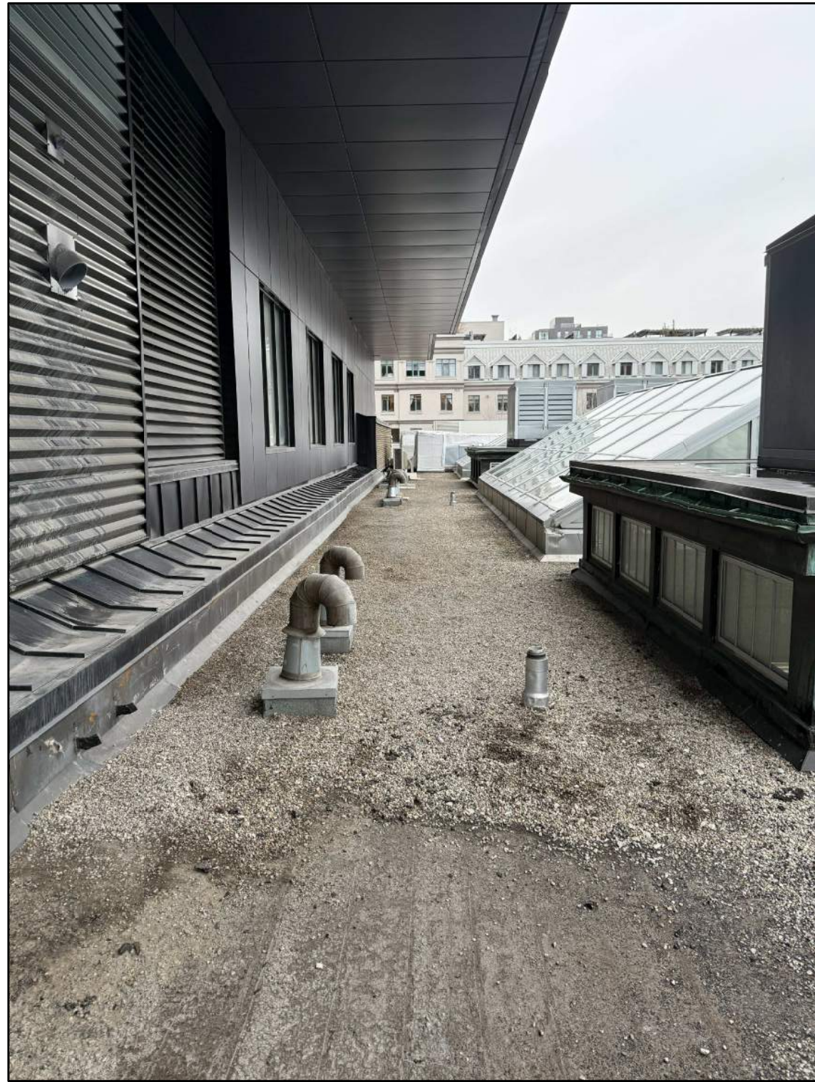
2 EXISTING GOOSENECKS & PLUMBING VENT M4 SCALE: N.T.S.
