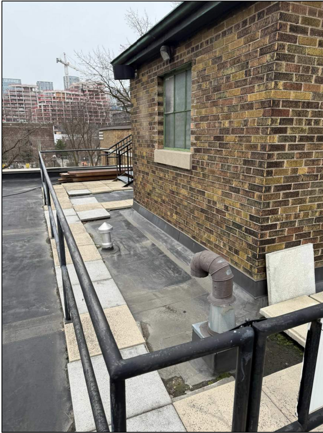
8 EXISTING GOOSENECKS AND PLUMBING VENT M5 SCALE: N.T.S.
