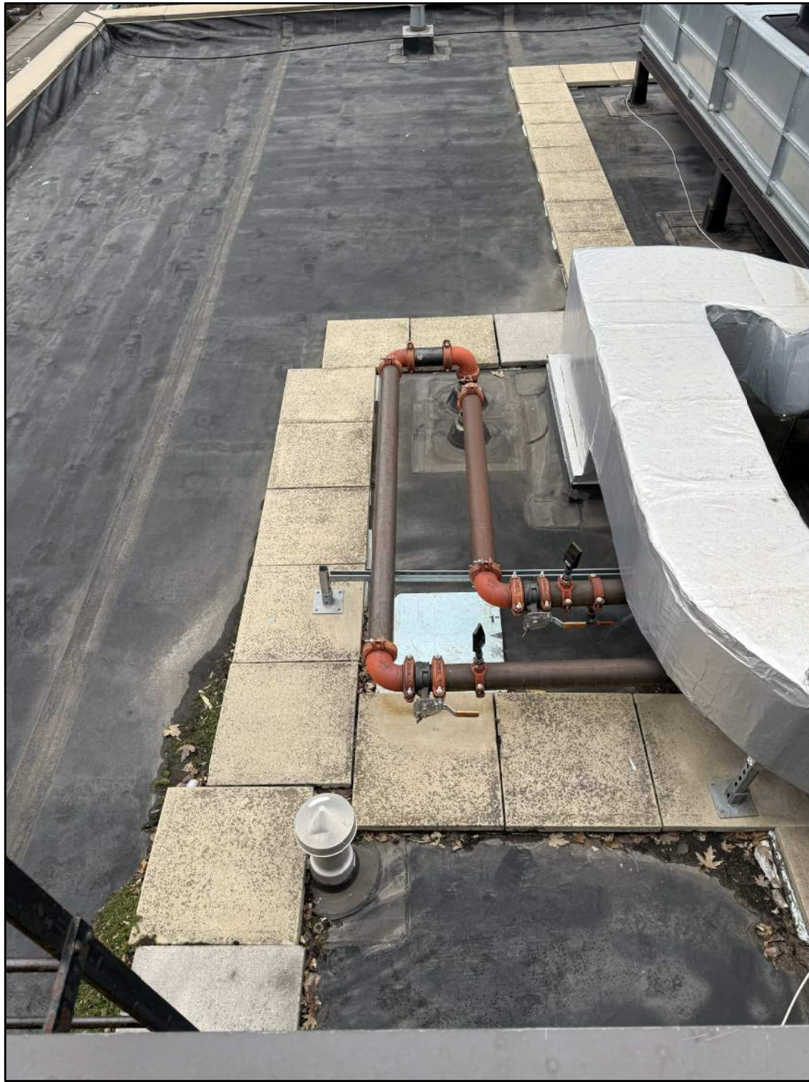
1 EXISTING PLUMBING VENT & FLUID COOLER PIPING M5 SCALE: N.T.S.
