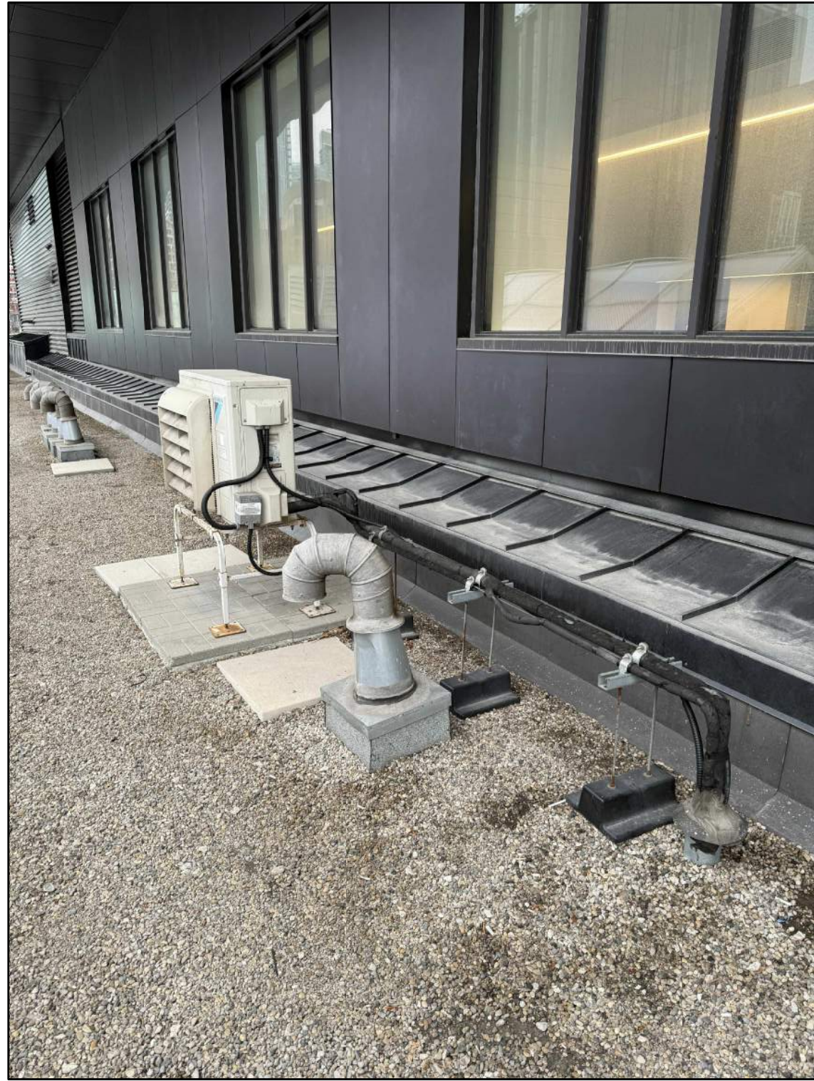
7 EXISTING CONDENSING UNIT, REFRIGERANT PIPING & GOOSENECKS M4 SCALE: N.T.S.
