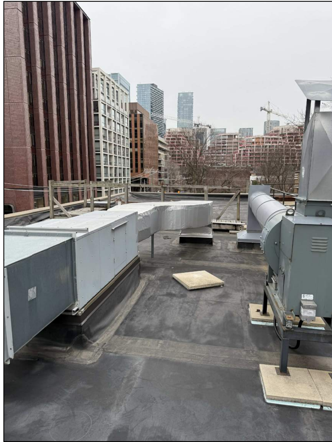
5 EXISTING MAKE-UP AIR UNIT 'MAU-1', DUCTWORK & 'KEF-1' M5 SCALE: N.T.S.
