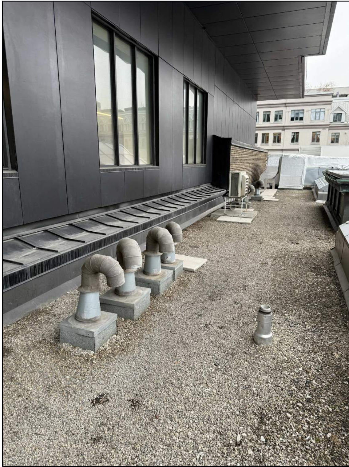
6 EXISTING GOOSENECKS & PLUMBING VENT M4 SCALE: N.T.S.
