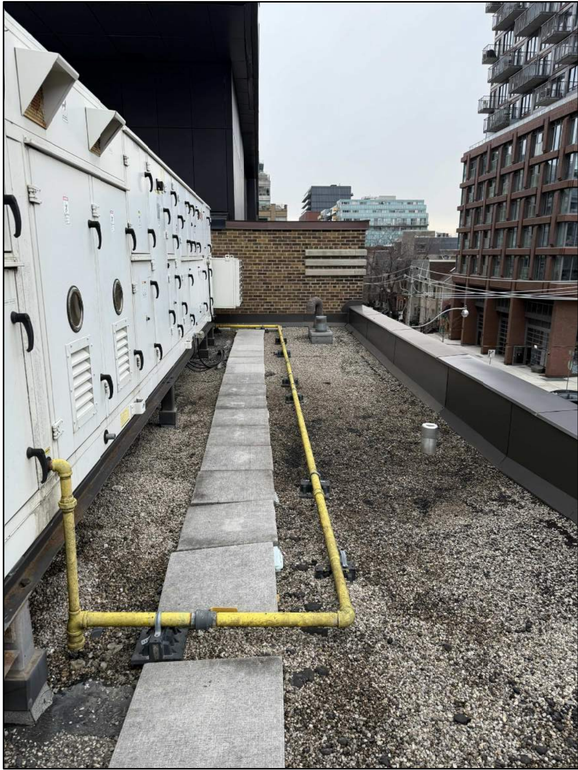
10 EXISTING GAS PIPING TO 'ERV-1' M4 SCALE: N.T.S.
