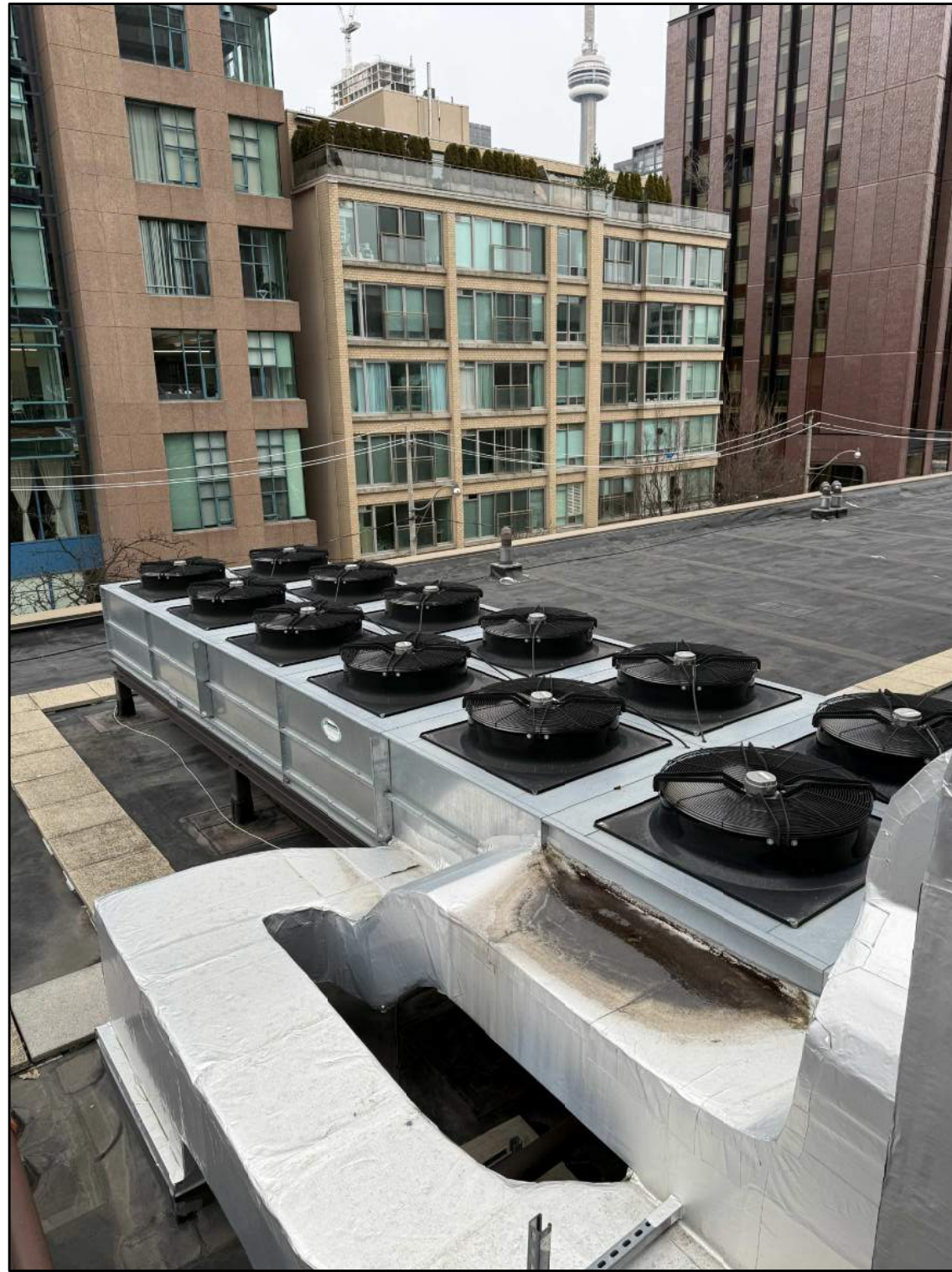
2 EXISTING FLUID COOLER 'FC-1' M5 SCALE: N.T.S.
