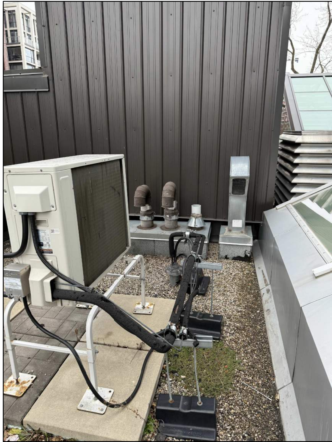
4 EXISTING CONDENSING UNIT, REFRIGERANT PIPING & GOOSENECKS M4 SCALE: N.T.S.
