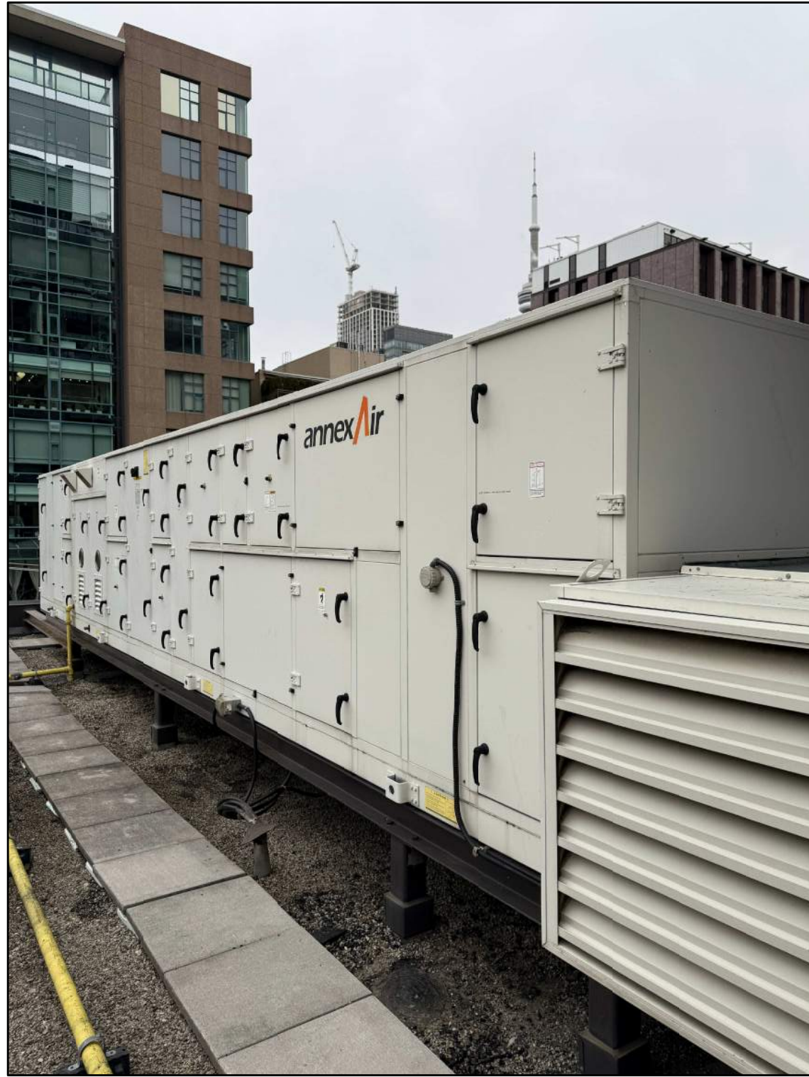
9 EXISTING 'ANNEX AIR' ERV-1 UNIT M4 SCALE: N.T.S.
