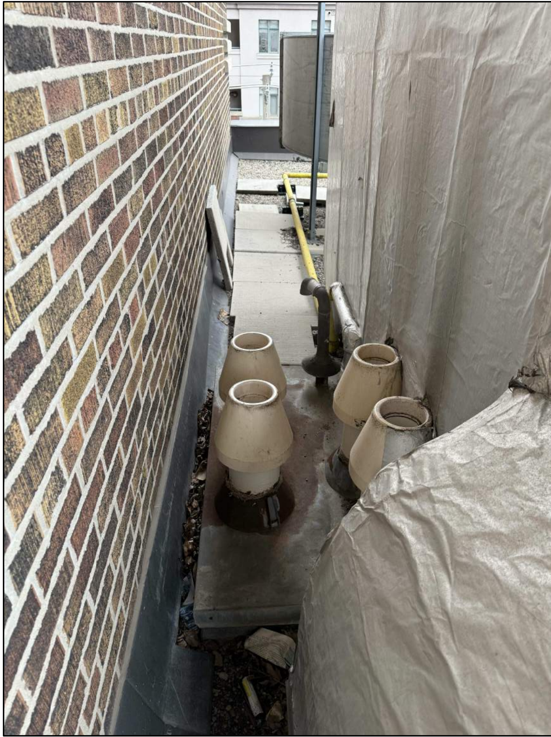
8 EXISTING COMBI-VENTS AND RELIEF VENTS M4 SCALE: N.T.S.
